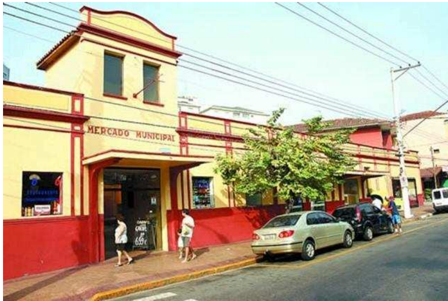
Fotografia 4 - fachada do Mercado Municipal, inaugurado em 1929 e tombado no ano de 2010 pelo Conselho Municipal.
