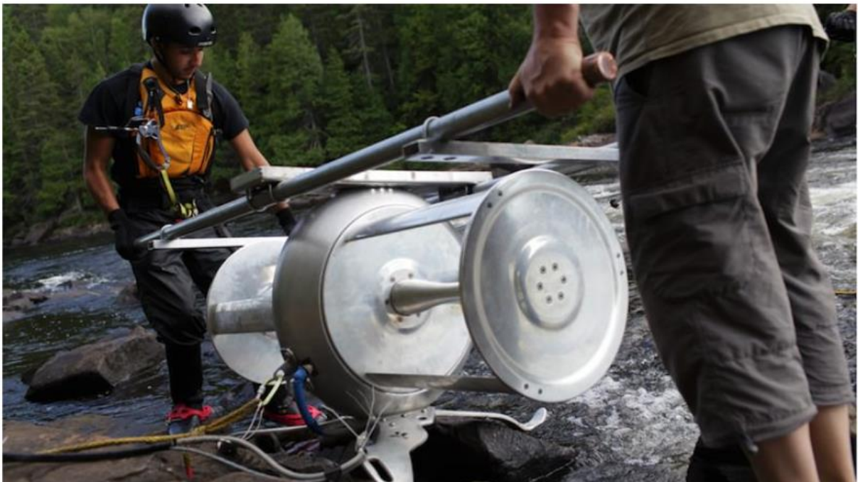
Figura 6 – Homens instalando turbina fluvial.
