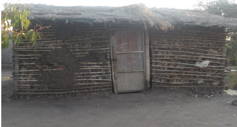
Figura 4: Fachada de uma moradia construída com barro, pedras e bambús no distrito de Nhamatanda. Fonte: O Autor, 2012
