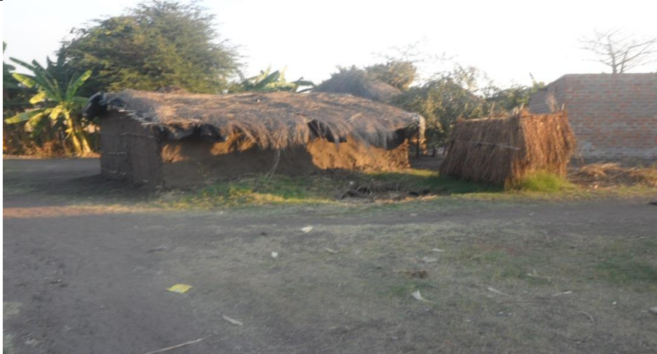
Figura 5: Parte Lateral de uma moradia construída de barro, bambú e caniço, e o respectivo sanitário de caniço ao lado.
